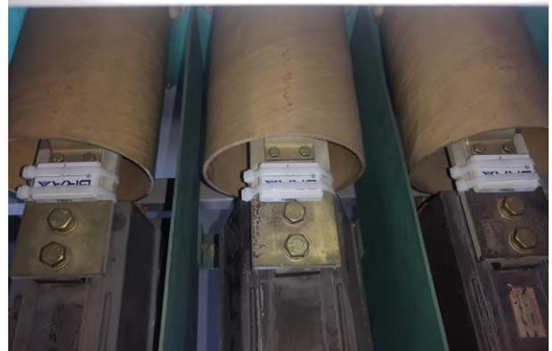
Figura 11 - Sensores de temperatura por contato na saída do disjuntor.
