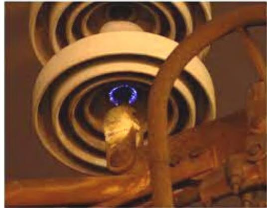
Figura 2 - DPs em isolador de tensão
