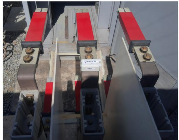
Figura 12 - Sensor de DPs, umidade e temperatura ambiente no braço do disjuntor.
