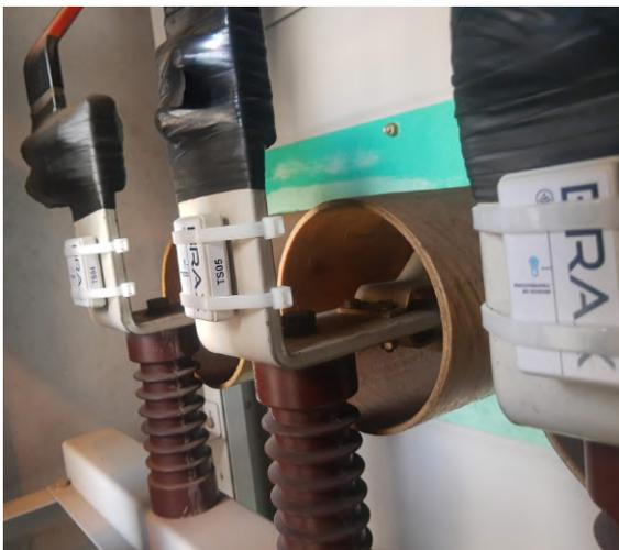
Figura 10 - Sensores de temperatura por contato na entrada do disjuntor.
