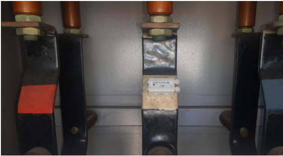
Figura 13 - Sensor de DPs, umidade e temperatura ambiente nas conexões de entrada e saída do cubículo.
